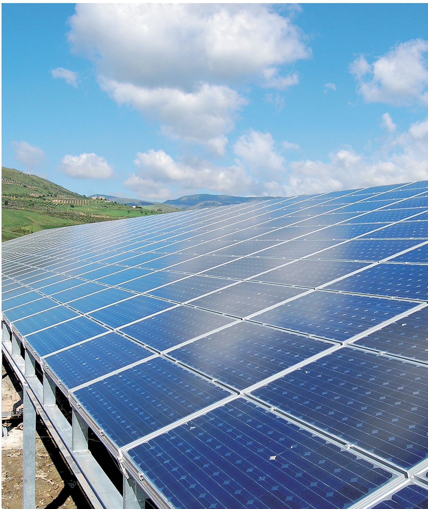
Referenceinstallation i Bivona (Italien): 425 kW nominal udgangseffekt –81 strenginvertere.
