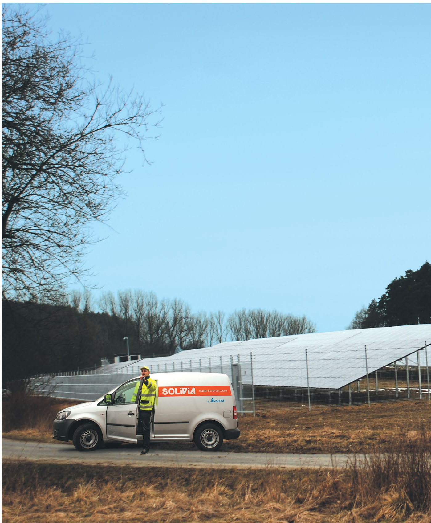
Referenceinstallation i Rütten (Tyskland): 1548 kW nominel udgangseffekt - 6420 solcellemoduler - 75 strenginvertere.
