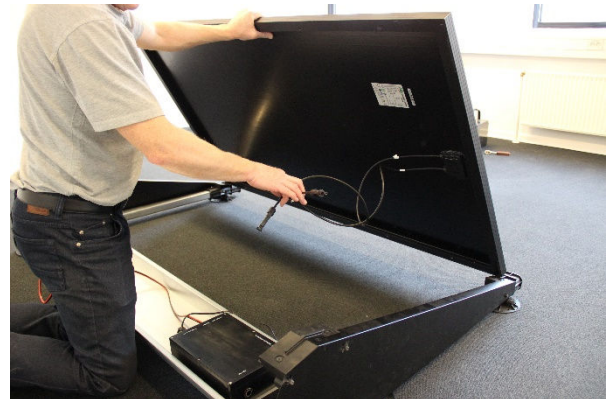
Husk at løsne ledningerne og føre dem bagud.
