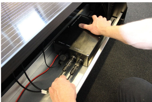
Stikkene fra panelet isættes nu i ladeboksen.
