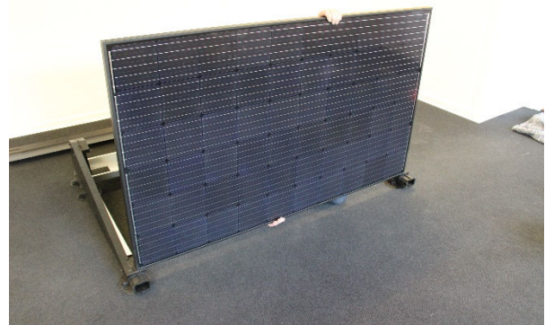
Panelet lægges nu på plads
